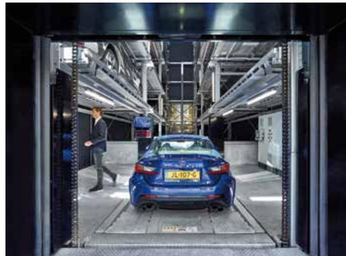
Der Übergabebereich ist besonders nutzerfreundlich ausgestattet. Sensoren überprüfen die Fahrzeugabmessungen und am Display wird der Fahrer durch den Parkvorgang geführt.
