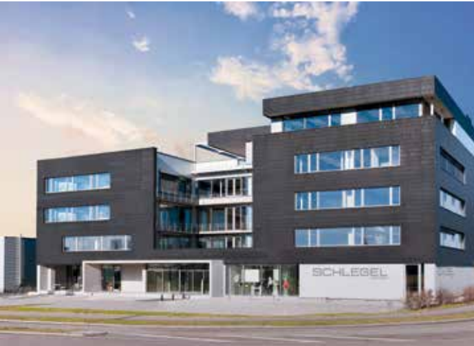
Schlegel Unternehmenszentrale, Bietigheim-Bissingen
