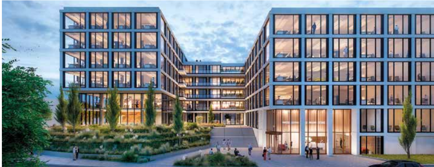
OFFICEHOME Am Pragsattel, Stuttgart-Feuerbach, Quelle: PANDION
