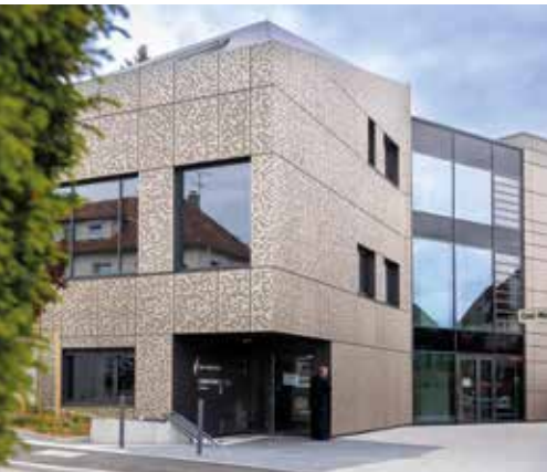
Neubau Landratsamt Röttestraße, Quelle: Yevhen Yermishyn
